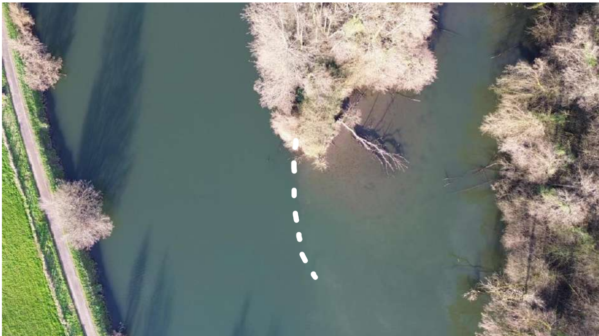
Figure 56. Vue zénithale de la digue basse de fermeture à l'aval de l'île
