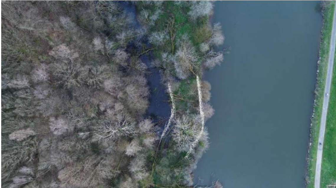
Figure 55. Vue zénithale du remblai rattachant la tête amont de l'île à la berge
